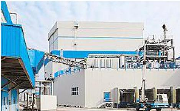
Il nuovo impianto realizzato dalla Surgital
